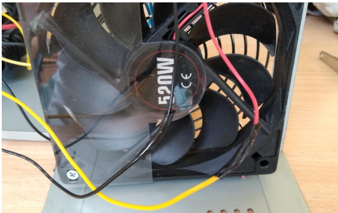
Rys. 15. Przylutowane przewody do wentylatora
