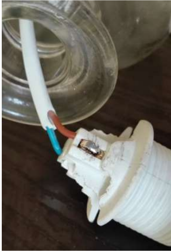
Rys. 14. Widok przylutowanych przewodów do oprawki.
