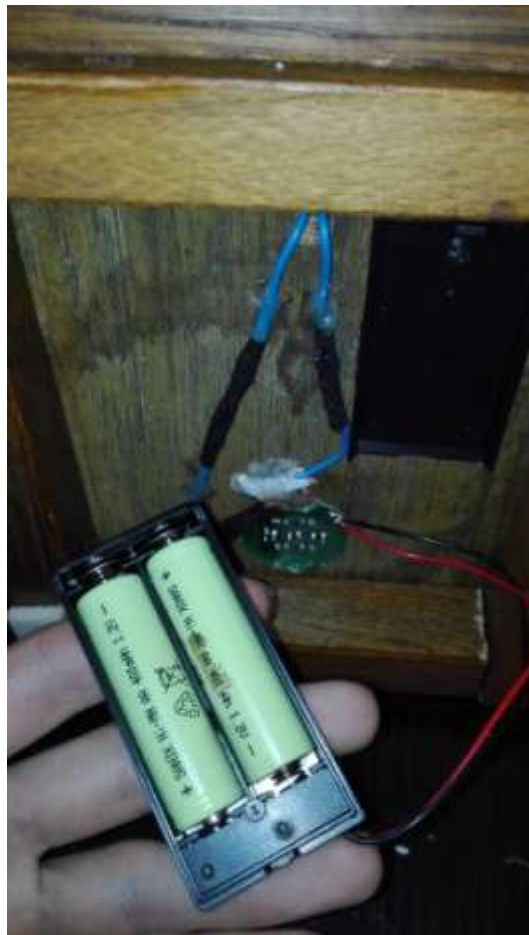
Rys. 18. Połączone już przewody wraz z włożonymi bateriami.
